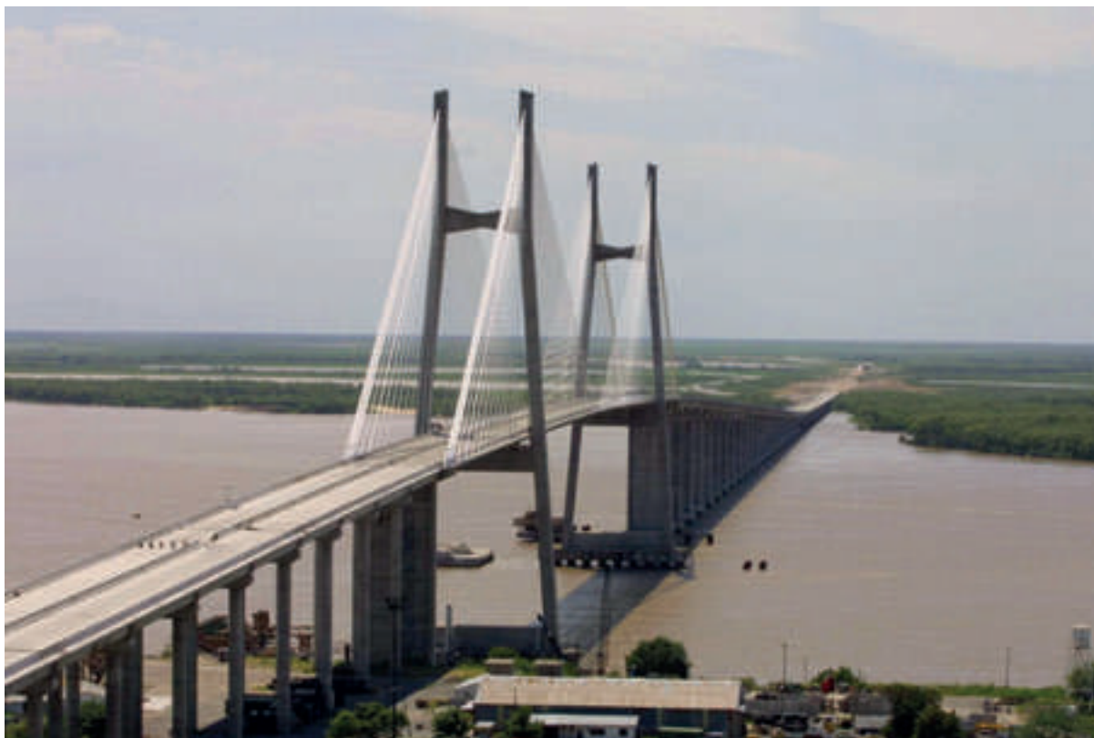
Puente Rosario Victoria.
