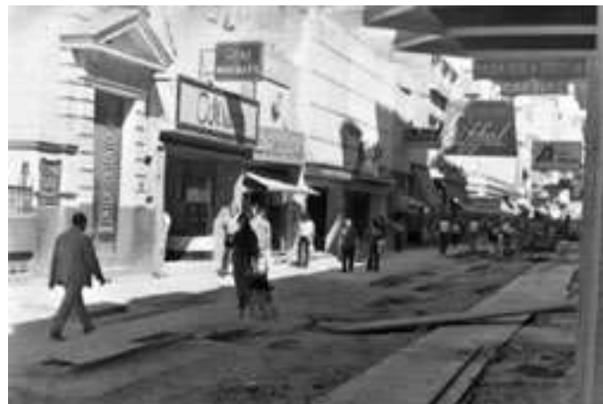
La construcción del paseo peatonal de calle Córdoba, desde Maipú a San Martín. Año 1970.
