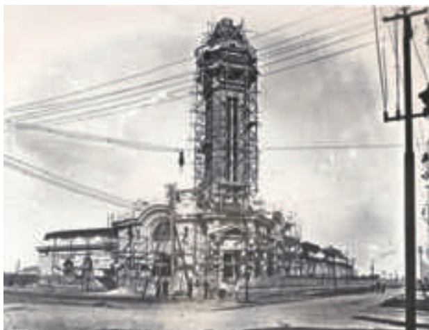
Edificio de la Estación del Ferrocarril Central Santa Fe (FCSF) en construcción, en la esquina de Cañerata y Santa Fe. Año 1929. Archivo diario "La Capital".
