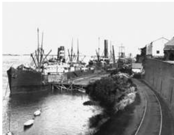
Muelle del Ferrocarril Central Argentino sobre el río Paraná a la altura de calle España. C. 1900. Richard Gaspary. Archivo Fotográfico de la Escuela Superior de Museología de la Municipalidad de Rosario.
