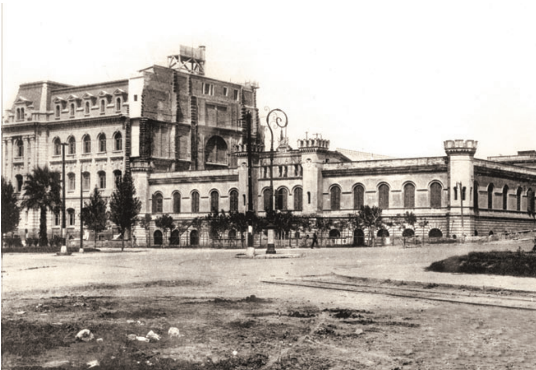
El nuevo edificio de la Aduana en construcción junto al ya existente, avenida Belgrano y Sargento Cabral. Año 1926. Colección del Ministerio de Obras Públicas. Escuela Superior de Museología.
